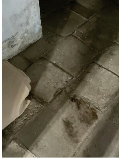
Fot. nr 7. Widok przed renowacją.
