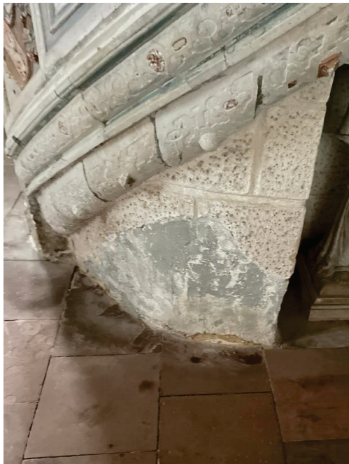
Fot. nr 8. Widok przed renowacją.
