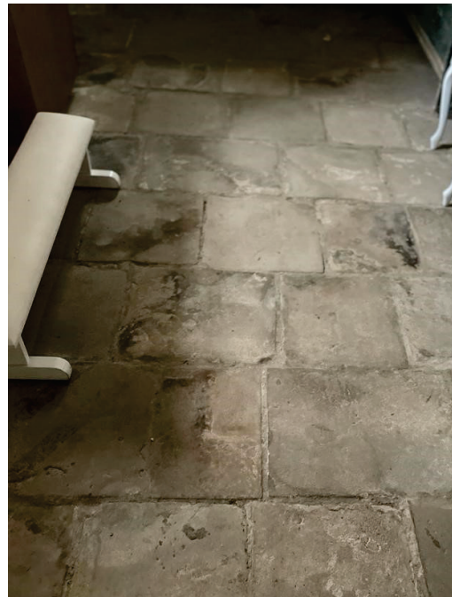
Fot. nr 9. Widok przed renowacją.
