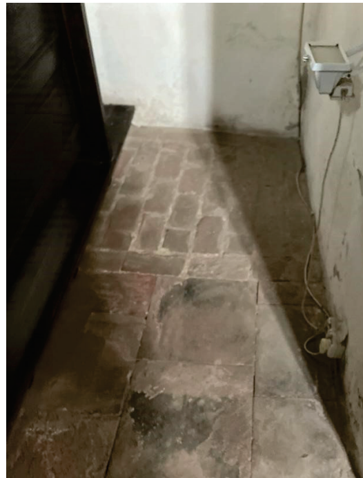
Fot. nr 13. Widok przed renowacją – widoczne ceglane uzupełnienia.
