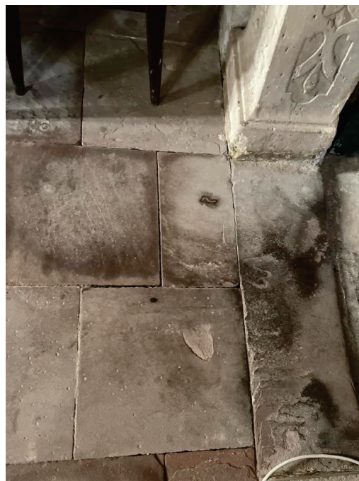
Fot. nr 5. Widok przed renowacją.
