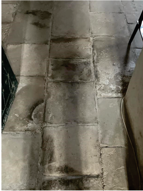
Fot. nr 6. Widok przed renowacją.
