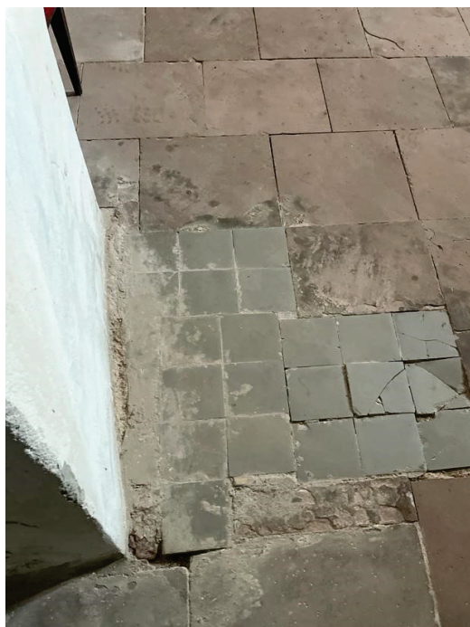
Fot. nr 14. Widok przed renowacją – widoczne ceramiczne uzupełnienia.
