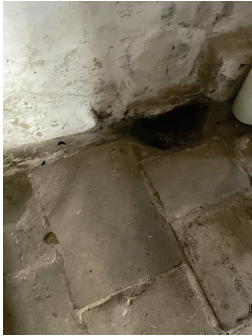
Fot. nr 10. Widok przed renowacją.
