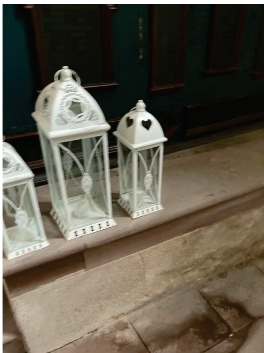
Fot. nr 2. Widok przed renowacją – zawilgocenia.
