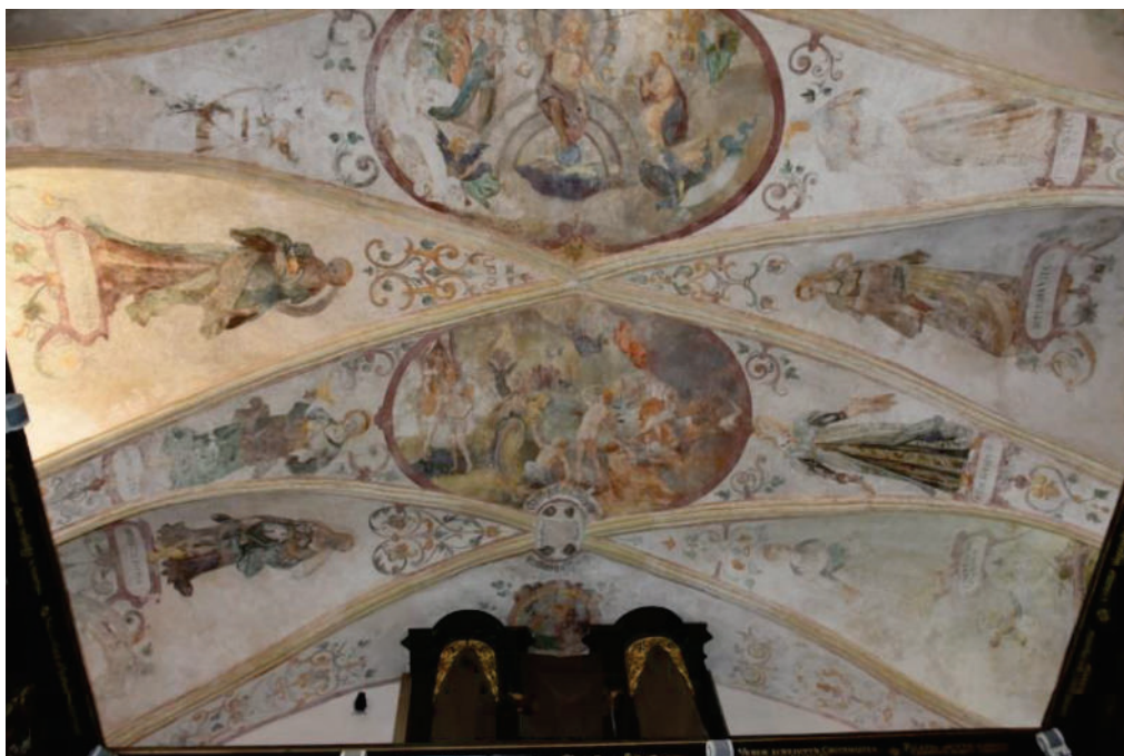
Fot. 5. Kościół pw. Świętej Trójcy w Żórawinie, wewnątrz kościoła, Widok na sklepienie nawy. Widoczne zabrudzenie i zaplamienia dekoracji malarskiej a także partie bardzo jasne, zanikające. Stan przed konserwacją, fot. I. Widlińska 2022
