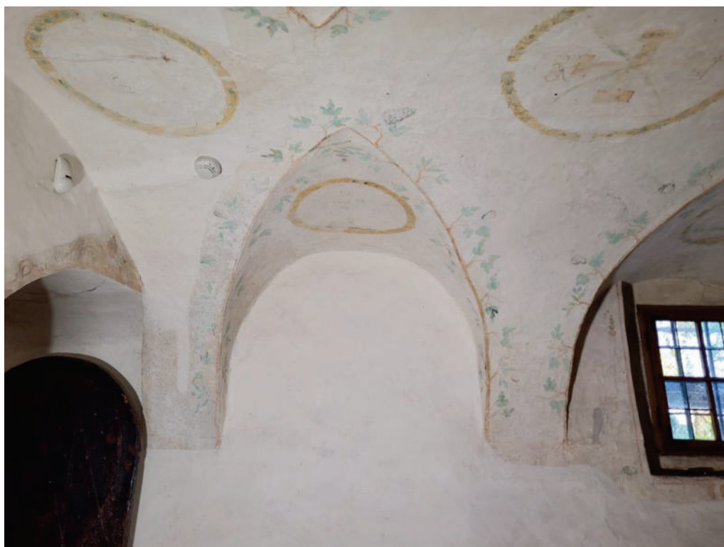
Fot. 8. Kościół pw. Świętej Trójcy w Żórawinie, wewnątrz kościoła, Widok na sklepienie zakrystii i ścianę północną. Widoczna bardzo jasna dekoracja malarska a także obmalowująca ją monochromia zakrywająca część dekoracji.. Stan przed konserwacją, fot. I. Widlińska 2022
