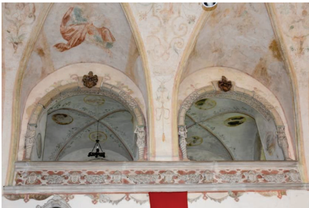
Fot. 7. Kościół pw. Świętej Trójcy w Żórawinie, wewnątrz kościoła, Widok na sklepienie prezbiterium i empyry nad zakrystią, Strona północna, Widoczna bardzo jasna i zanikająca dekoracja malarska. Stan przed konserwacją, fot. I. Widlińska 2022
