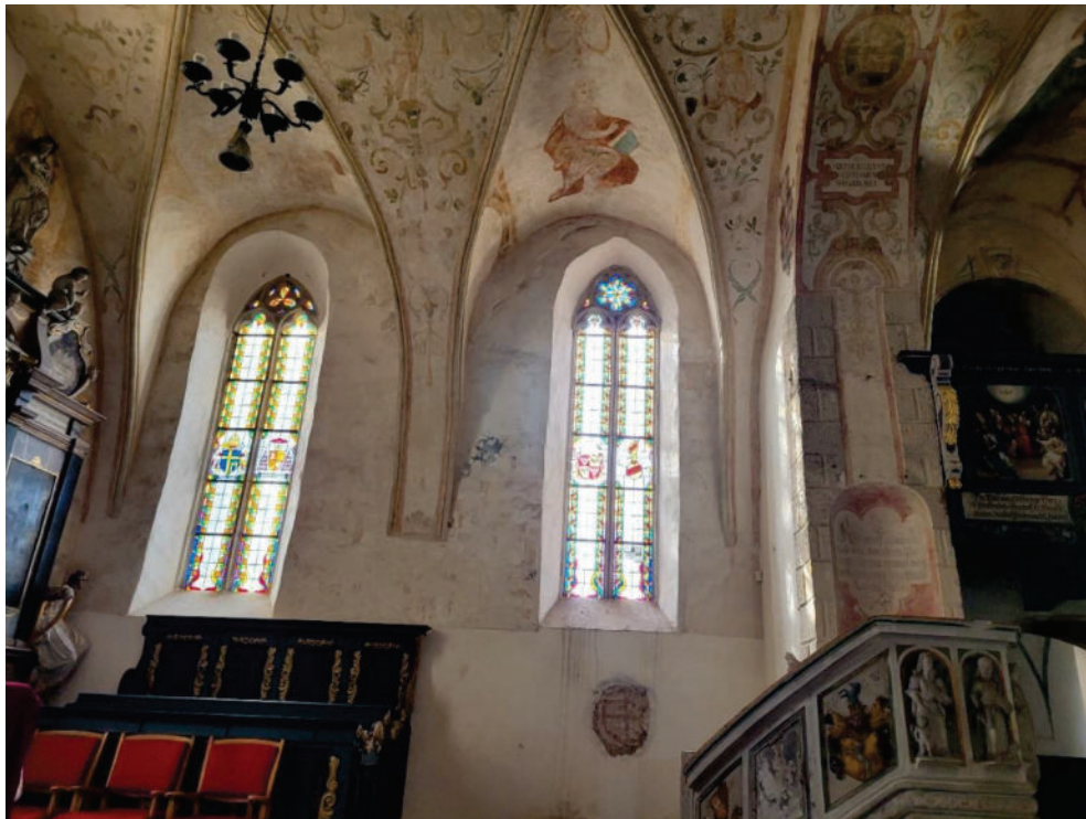
Fot. 20. Kościół pw. Świętej Trójcy w Żórawinie, wewnątrz prezbiterium kościoła, Widok na ścianę południową sklepienia. Widoczny w dolnej partii ściany zacheuszek eksponowany w formie odkrywki. Stan przed konserwacją, fot. I. Widlińska 2022
